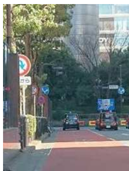
←西区南幸 バス・タクシー専用車線の 表示が消えている 先の左折禁止表示がわかりづらい
